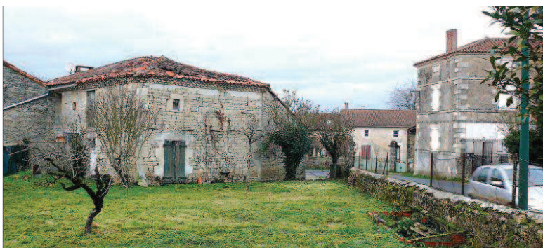
Un passage piéton sera créé dans le jardin de la maison Pasquet le long du muret pour pallier la largeur insuffisante de la rue. Photo CL
